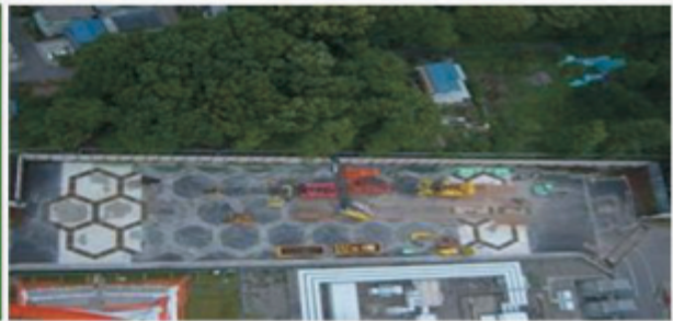
都内事業所からの振動遮断WIB工事
