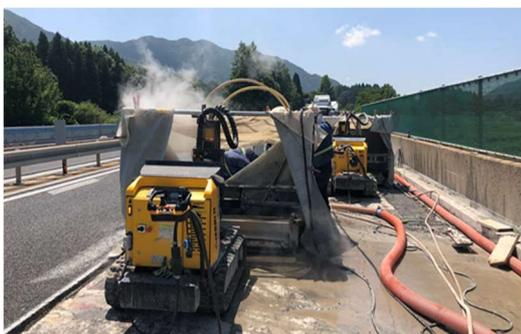
この方法では、①通行規制の期間が全面取替に比較して大幅に短縮でき、規制範囲も部分的な車線規制で施工が可能になる。②撤去するコンクリート量は全面取替の約1/2以下であり、産業廃棄物の削減が可能。③全面取替案と比較して規制費用も含めた工事費用が約30%削減できるといったメリットがあります。
